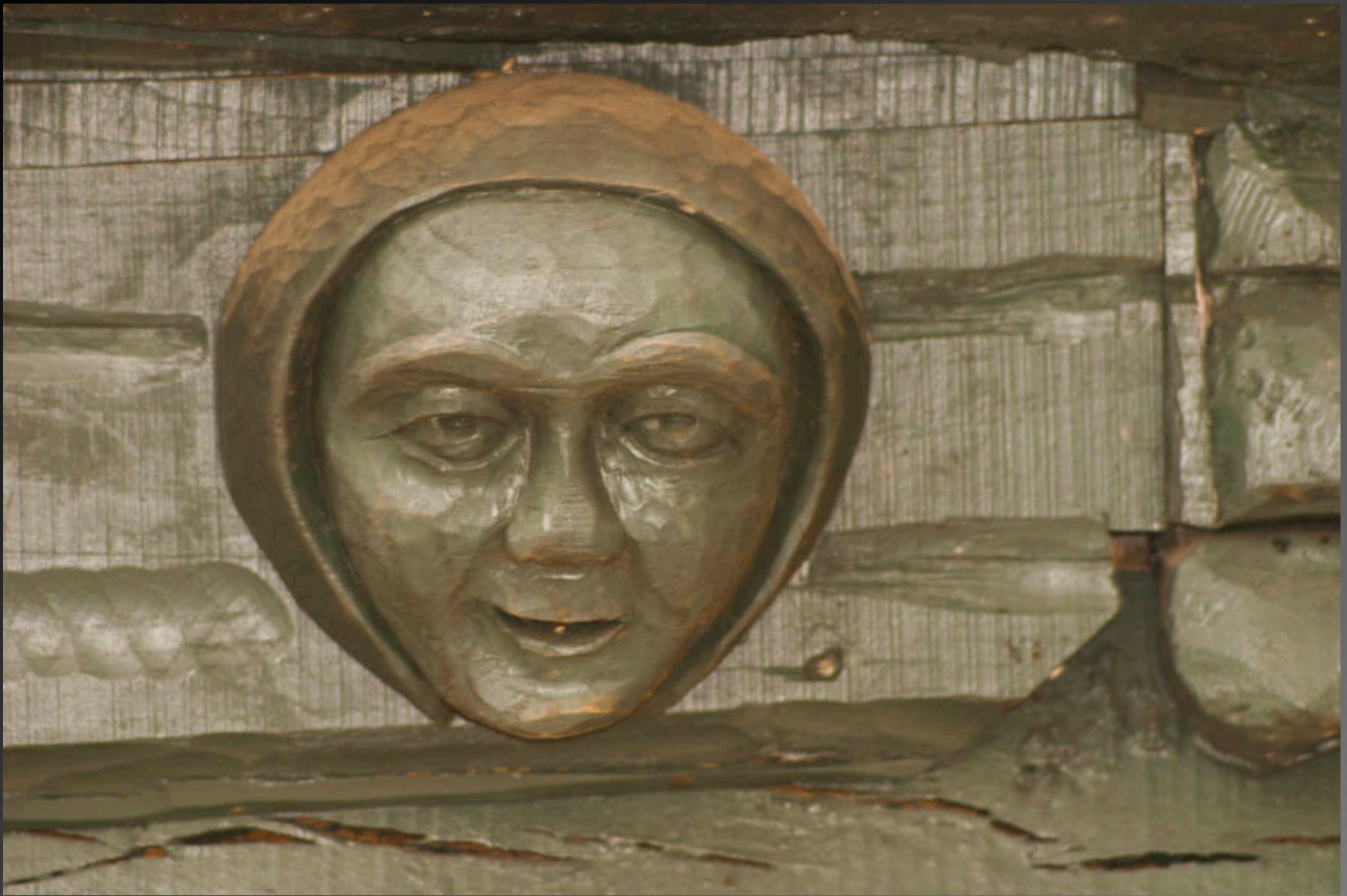
Pontivy, Door Lintel
